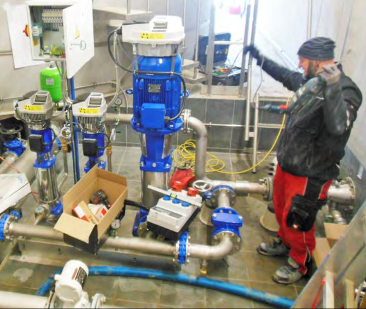
Im Oktober und November liefen parallel die Restarbeiten im Hochbehälter. Es wurden Rohrleitungen, Elektroinstallation, Schaltschränke, Druckerhöhungspumpen etc. eingebaut.
